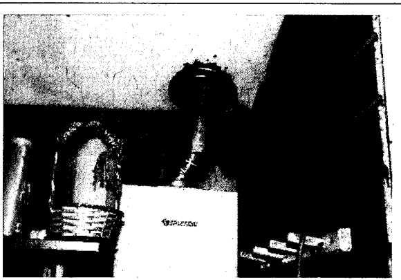
Fotografía N° 14: Unión de dos conductos de evacuación de gases, Calle Las Tepas N° 816, Coyhaique.
