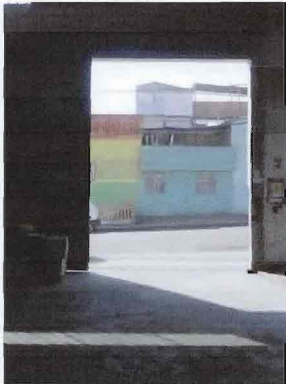
Acceso de bodega sin cortinas de plástico
