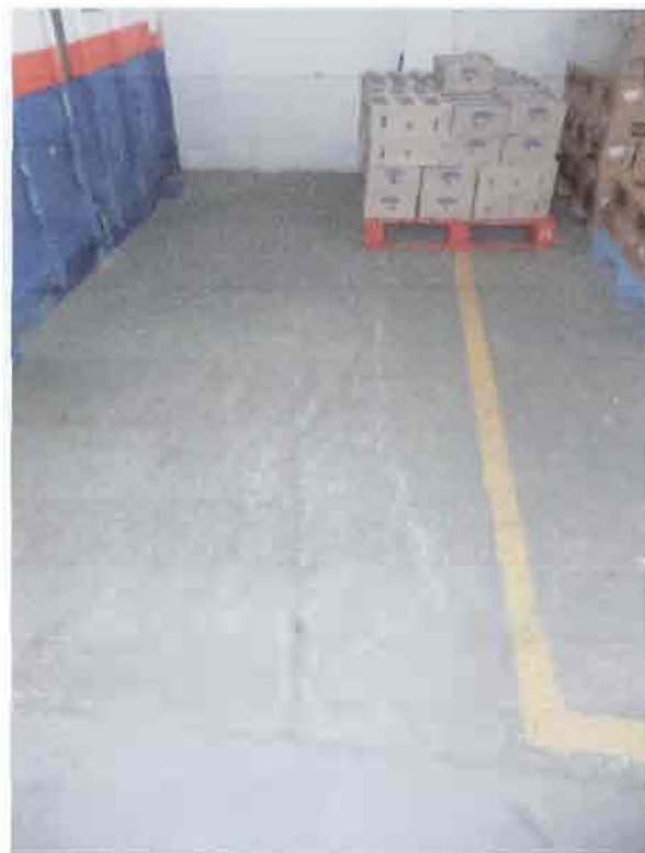
Superficie porosa y de cemento
