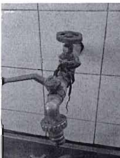
Escuela El Guindo Alicopsa S.A. – Ovalle
